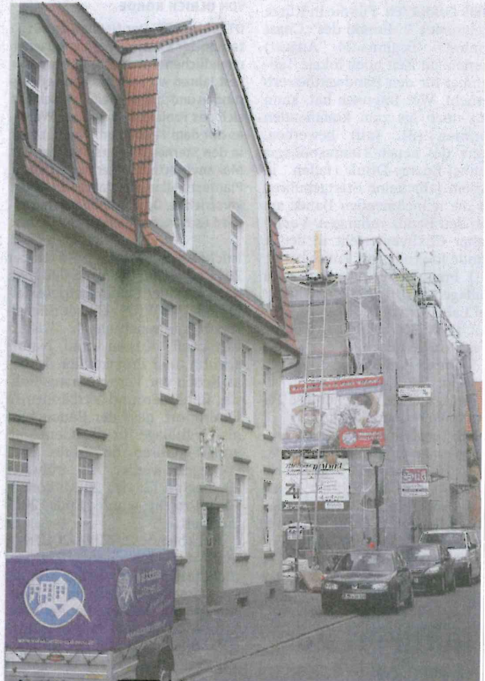
In der Bauvereinsstraße sanieren die Wohnstätten gerade das Haus, mit dem vor 105 Jahren ihre Geschichte begann. Auf dem bereits sanierten Nachbarhaus kommt schon Solartechnik zum Einsatz. Foto: Krieschen
